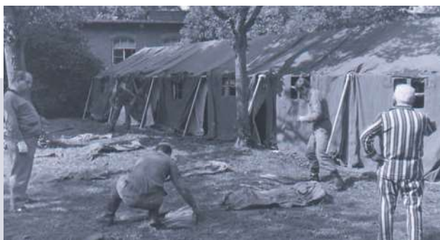
Armeezelte dienten Ende der 1960er Jahre zeitweise als Provisorium, als eine Sanierung der alten Lazarettgebäude anstand, die über fast 90 Jahre die Dermatologie in Erlangen beheimateten.
